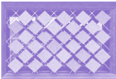
1 Die Adaptive Solar Façade, installiert am modularen Forschungs- und Innovationsgebäude NEST, Dübendorf, Schweiz, 2022
