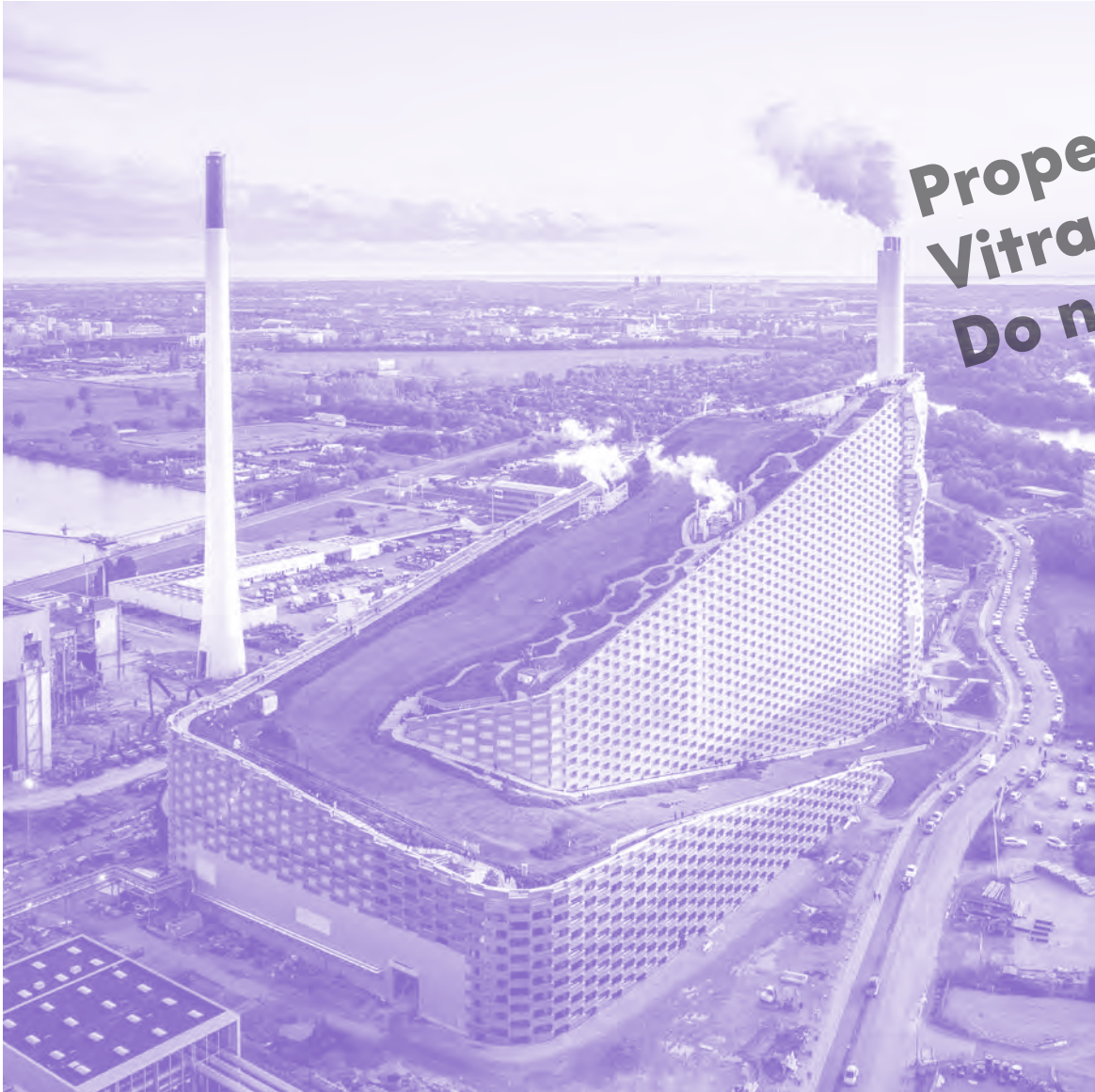
15 Müllverbrennungsanlage und Freizeitpark: CopenHill von BIG, 2019
