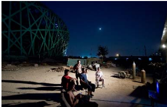
13 Iwan Baan, Baustelle des Nationalstadions, Peking, China, 2007, Architektur: Herzog & de Meuron © Iwan Baan
